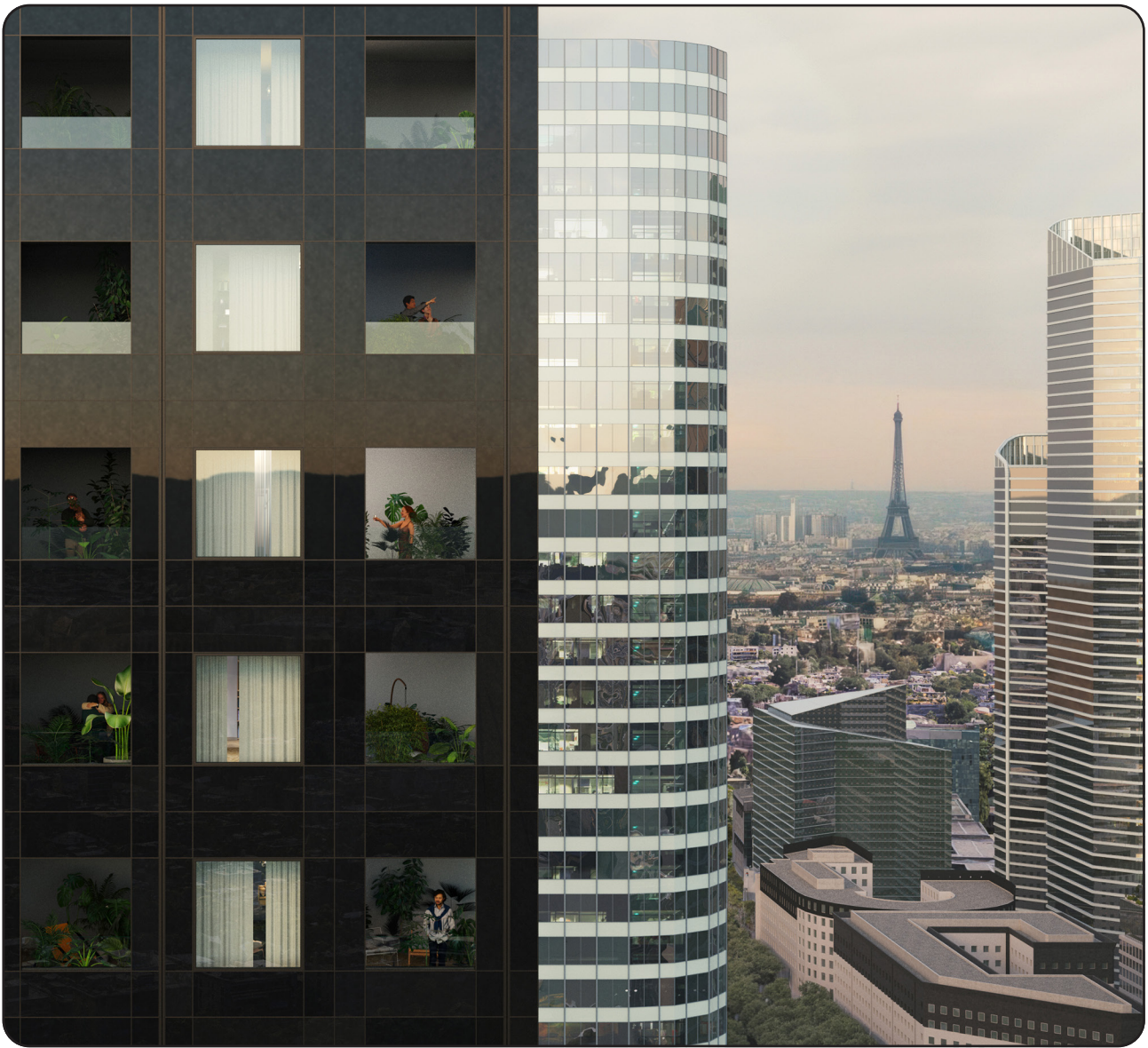
Tour Areva — Vue extérieure. © Chartier Dalix
